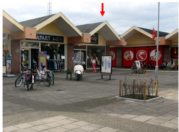
Figuur 6. Een overzicht van de locatie van het te slopen pand aan de zuidzijde. De rode pijl geeft het te slopen pand zelf aan.
