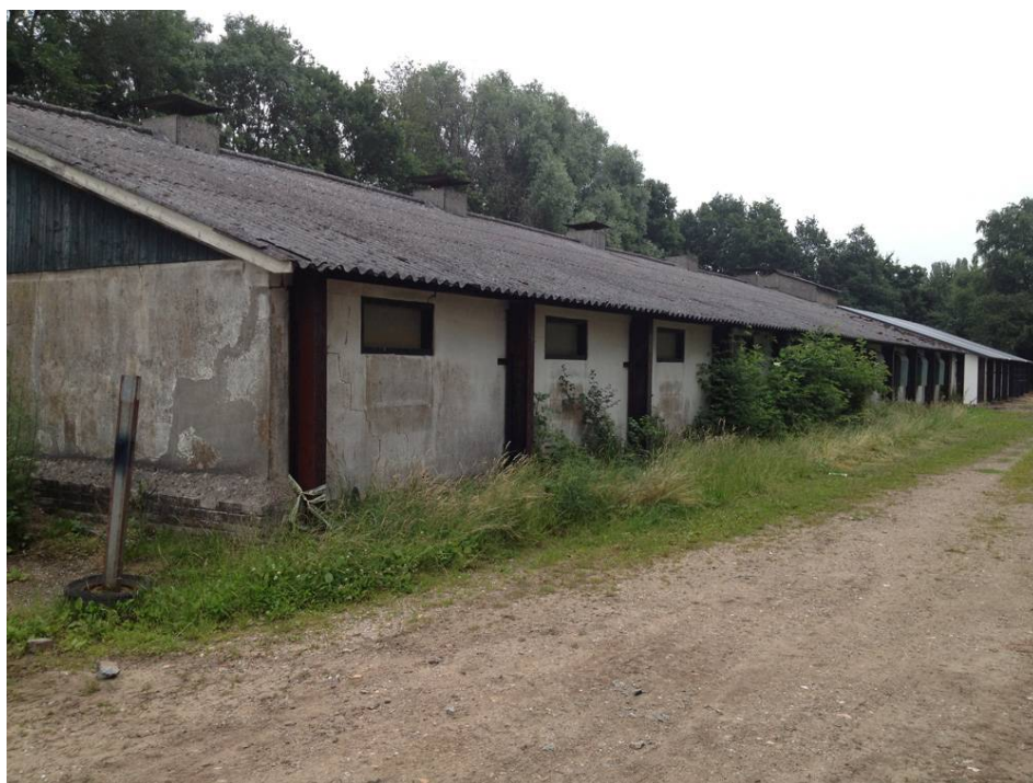
Figuur 2. Deel van de te slopen stallen.
