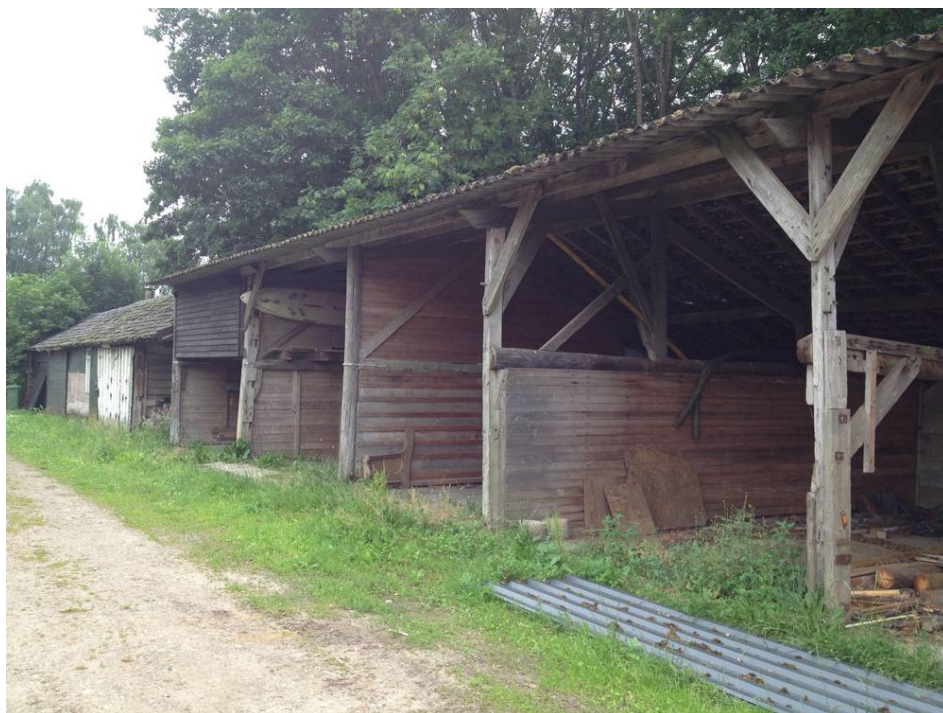
Figuur 3. Te slopen kapschuren.
