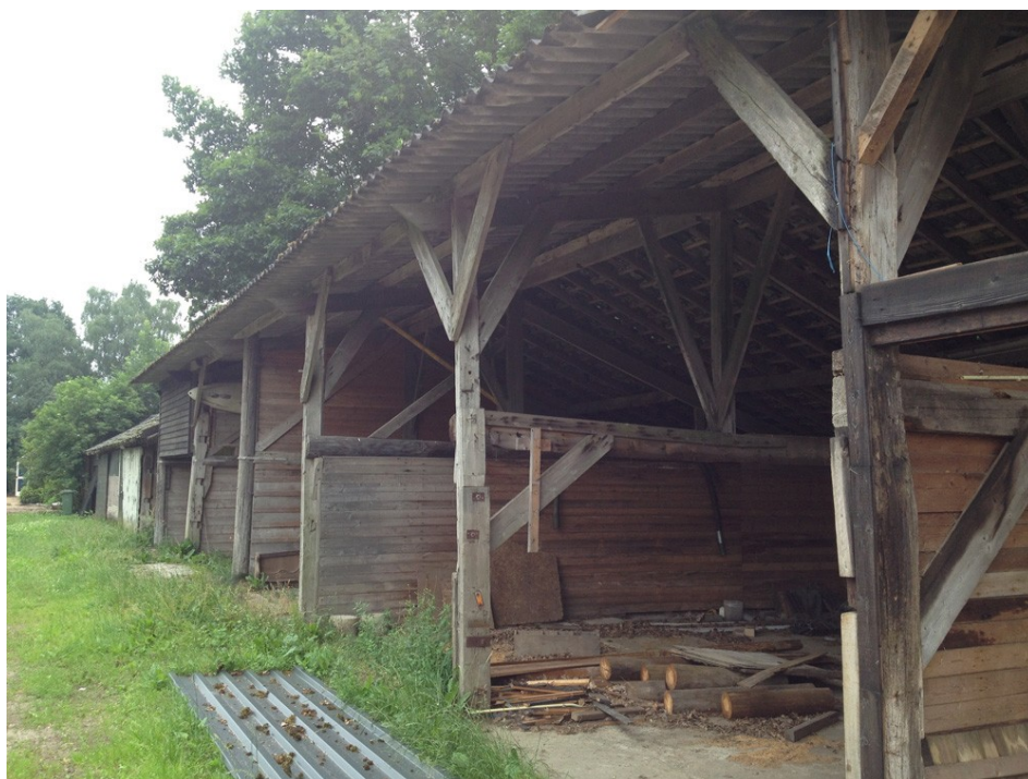
Figuur 2. Meest zuidelijke, houten schuur met dak van golfplaten.
