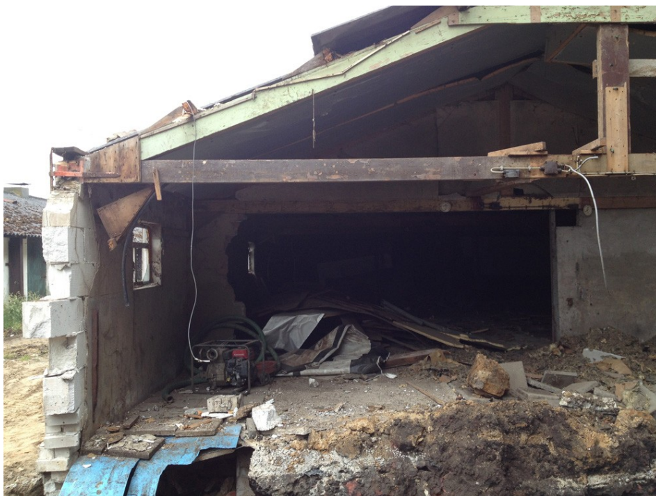
Figuur 5. Opeengebroken deel van de noordelijke schuur.
