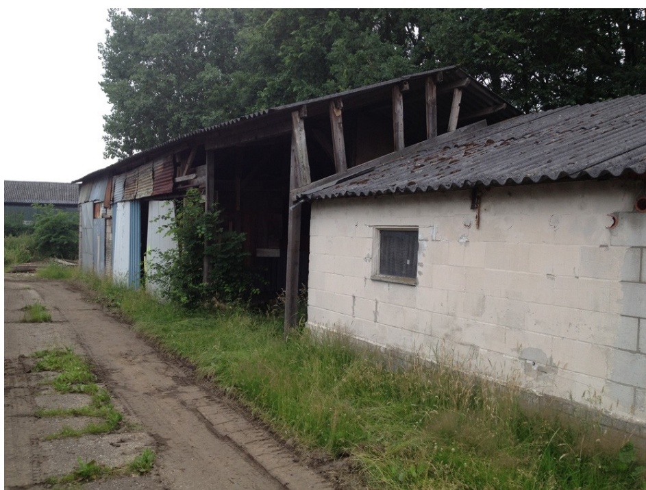
Figuur 3. Deel van de noordelijke schuur, voornamelijk bestaande uit een houten constructie en golfplaten, en ten dele opgetrokken met een enkelwandige betonnen muur.
