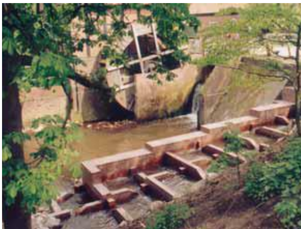
Figuur 6.4. Vispassage vervaardigd uit bakstenen (links) en rechts een vertical slot vispassage met enkel slot, vervaardigd uit beton met houten afscheidingen (in sponning) (bron: FAO).
