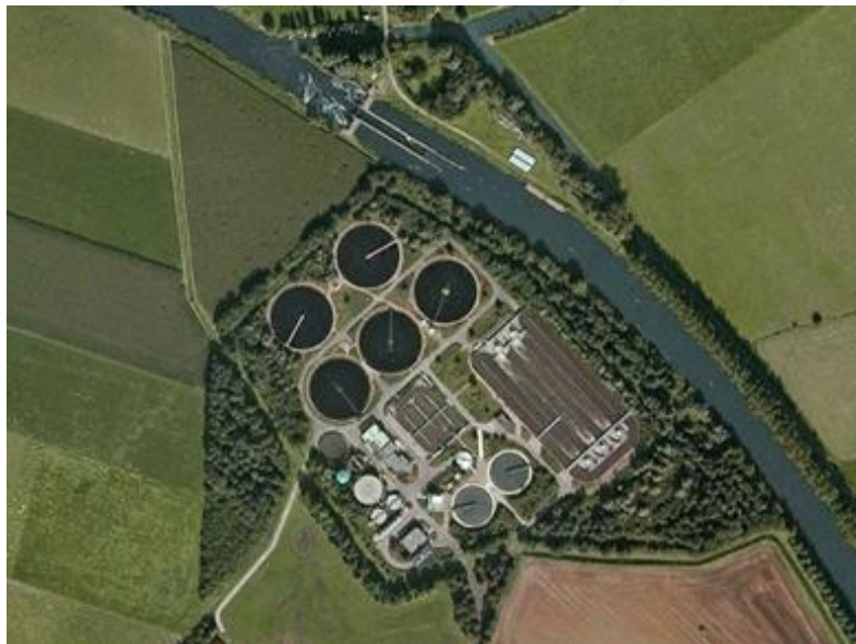
Figuur 2.1. Sluis- en stuwcomplex de Pol met daaronder de RWZI Etten (bron afbeelding: Google Earth/Aerodata International Surveys, 2013).
