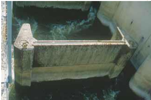
Figuur 6.2. Voorbeeld van een vertical slot vispassages met twee slots (FAO, 2002).
