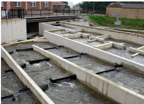
Figuur 6.1. Vertical slot vispassage in werking (links, www.overmaas.nl ) en rechts de opbouw van een vispassage (nog niet in werking) met aangestorte bodem.
