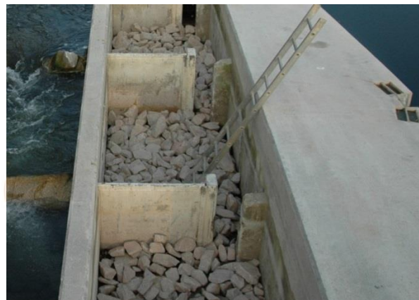
Figuur 6.1. Vertical slot vispassage in werking (links, www.overmaas.nl ) en rechts de opbouw van een vispassage (nog niet in werking) met aangestorte bodem.
