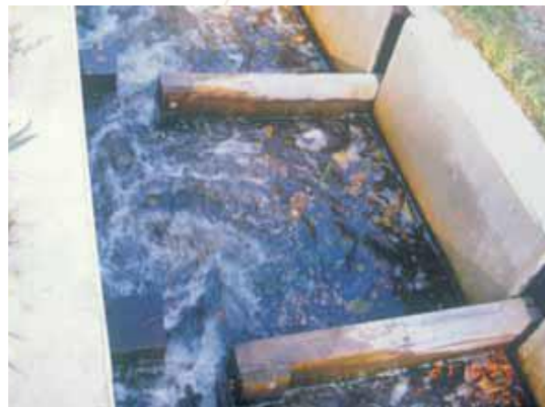
Figuur 6.4. Vispassage vervaardigd uit bakstenen (links) en rechts een vertical slot vispassage met enkel slot, vervaardigd uit beton met houten afscheidingen (in sponning) (bron: FAO).
