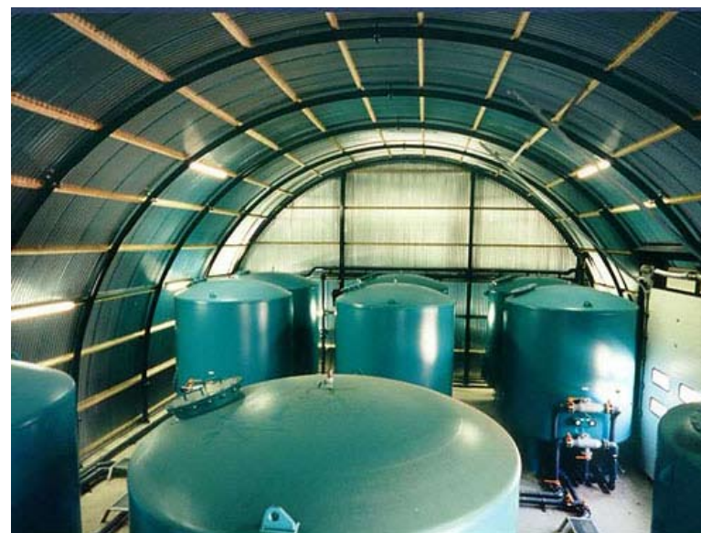
E17. Referentie zandfilters (ruimtebeslag 400m 2 ) (bron: Logisticon)
