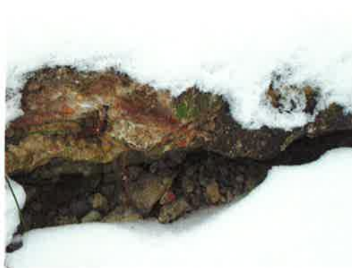
Funderingsresten (puin onder het beton)
