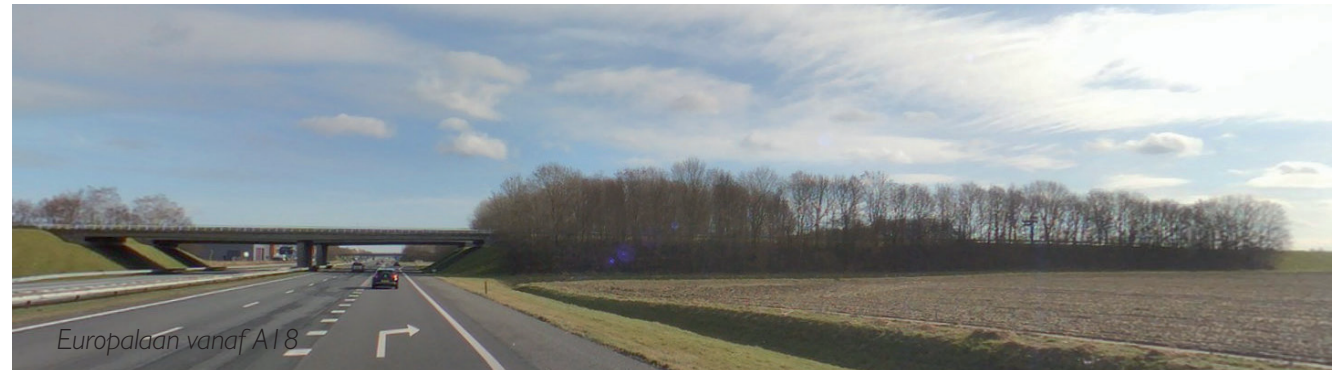
fig.: 18 Beelden van de bestaande beplantingen op de taluds van met de A18 kruisende wegen.
