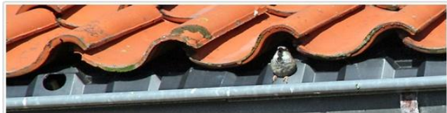
Figuur 7: vooraanzicht vogelvide onder eerste rij dakpannen (bron: Vogelbescherming)
