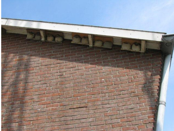
Broedende boerenwaluwen tegen de zuidgevel kapschuur
