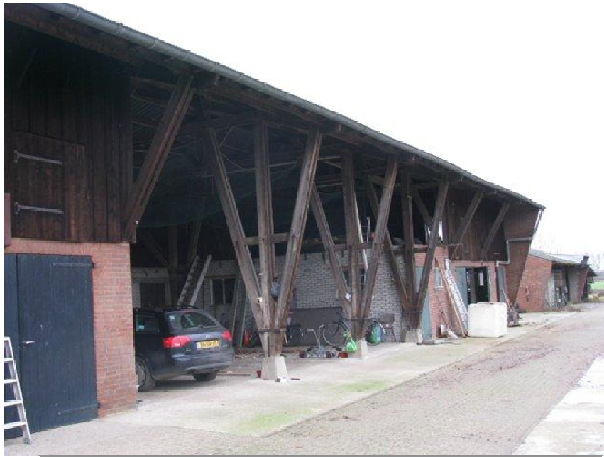
Karakteristieke kapschuur met spanten (te verbouwen tot woning)
