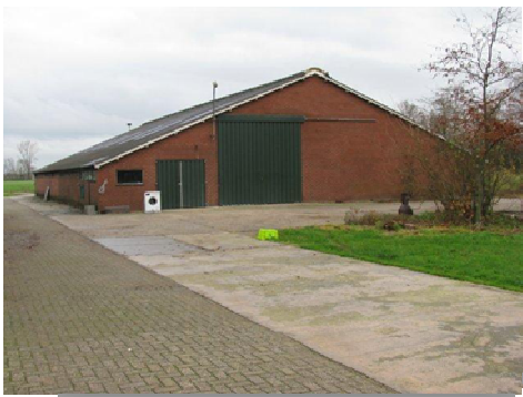
Te saneren loopstalschuur, locatie nieuwbouw woning 2 (oost)
