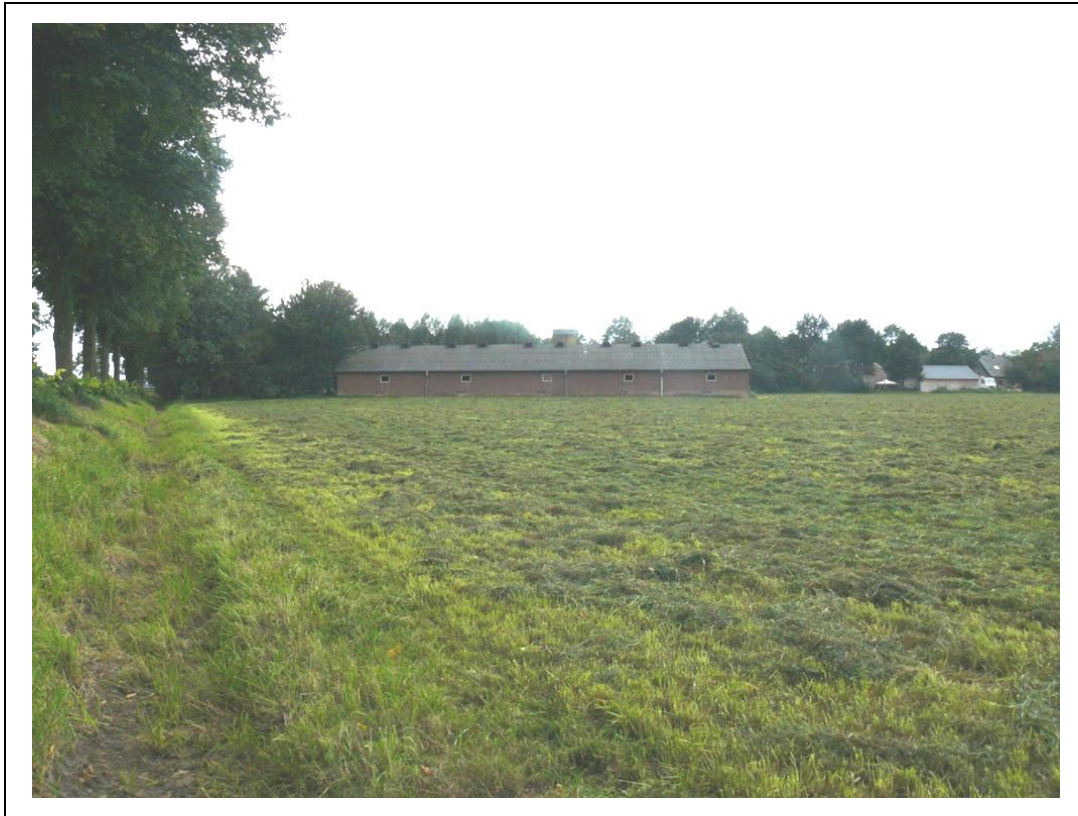
Foto 5. Varkensstal gezien vanuit oostelijke richting (links de Berghseweg)
