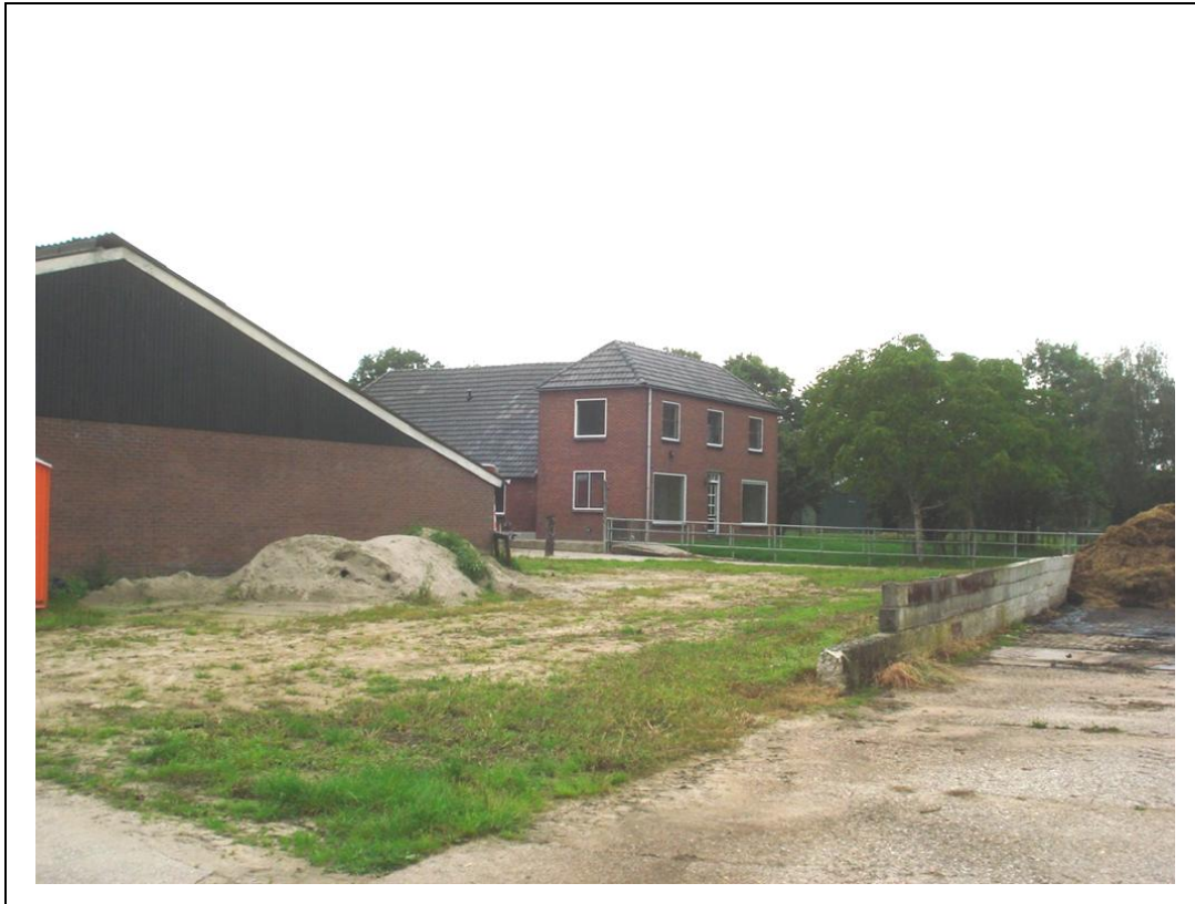
Foto 3. Woonboerderij Vicarisweg 35 met op de voorgrond de te slopen stal
