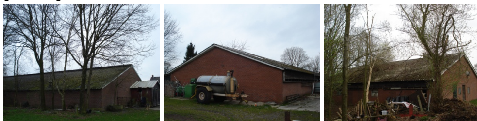
Foto's: De te slopen opstallen A en B en de te verbouwen opstal C.
