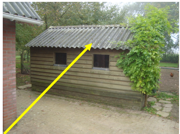
Afbeelding 12: schuur B/golfplaten op het dak
