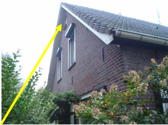
Afbeelding 9: Nr 5/ buitenzijde/beplating overstekken
