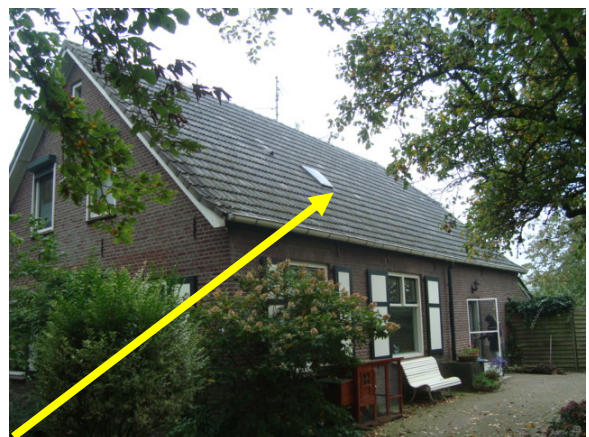
Afbeelding 6: Nr 5/ buitenzijde/dakbeschoot woning
