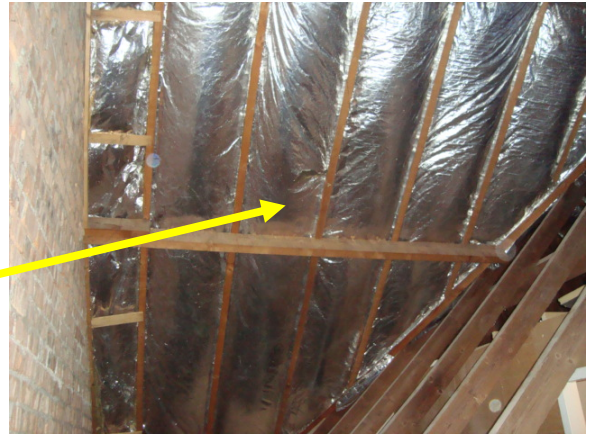
Afbeelding 8: Nr 5/ buitenzijde/dakbeschoot woning
