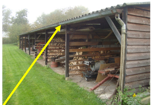
Afbeelding 16: broeikas/golfplaten op houtopslag
