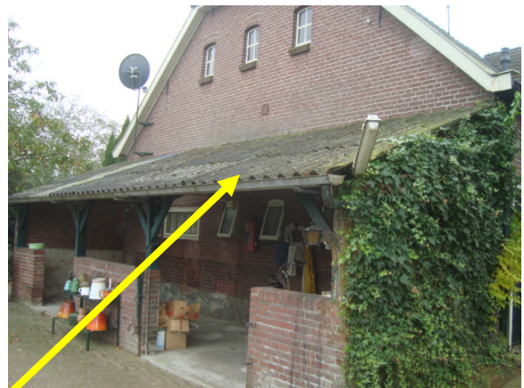
Afbeelding 4: Nr 5a/ buitenzijde/golfplaten op overkapping
