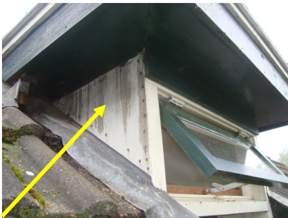
Afbeelding 3: Nr 5a/ buitenzijde/zijwangen dakkapel
