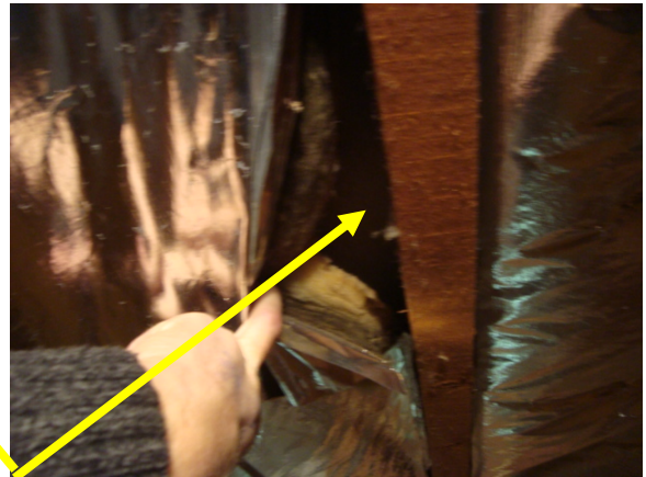
Afbeelding 2: Nr 5a/ buitenzijde/dakbeschoot woning
