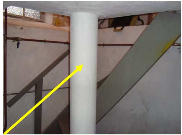
Afbeelding 10: nr 5/ binnenzijde/pilaar in kelder
