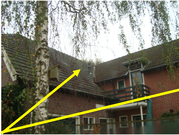
Afbeelding 7: Nr 5/ buitenzijde/dakbeschoot woning
