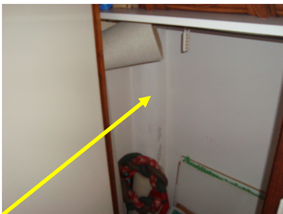
Afbeelding 5: nr 5a/ binnenzijde/ventilatiepijp
