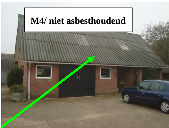
Afbeelding 11: schuur A/golfplaten op het dak
