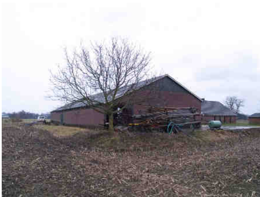
Zicht op het plangebied met de te slopen stal
