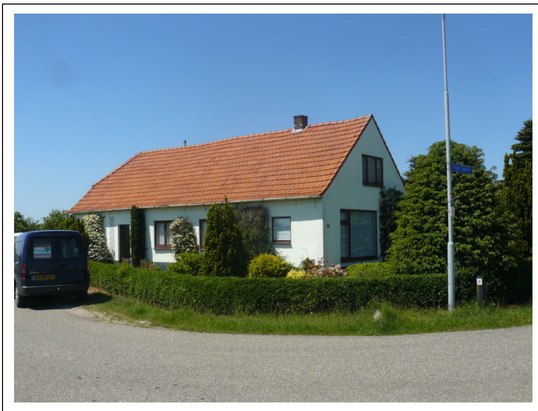
Foto 1. Woonhuis, ruimte onder dakpannen is geschikt als zomerverblijf voor vleermuizen.
