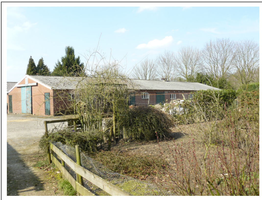
Foto 1. Te slopen varkensschuren.
