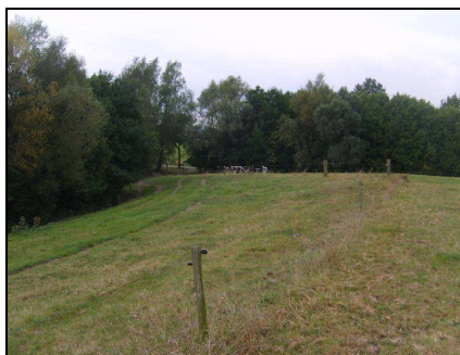
Bestaande situatie: toegang gezien vanuit plangebied
