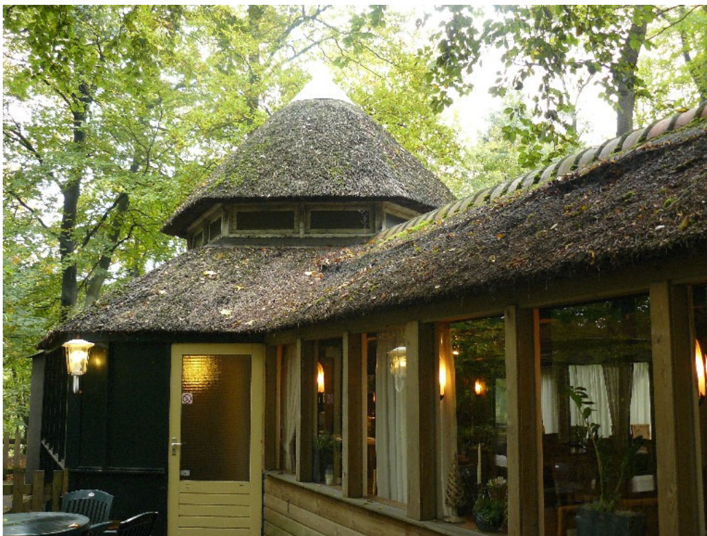
Foto 2. Het restaurant is voorzien van een koepel en rieten dak.
