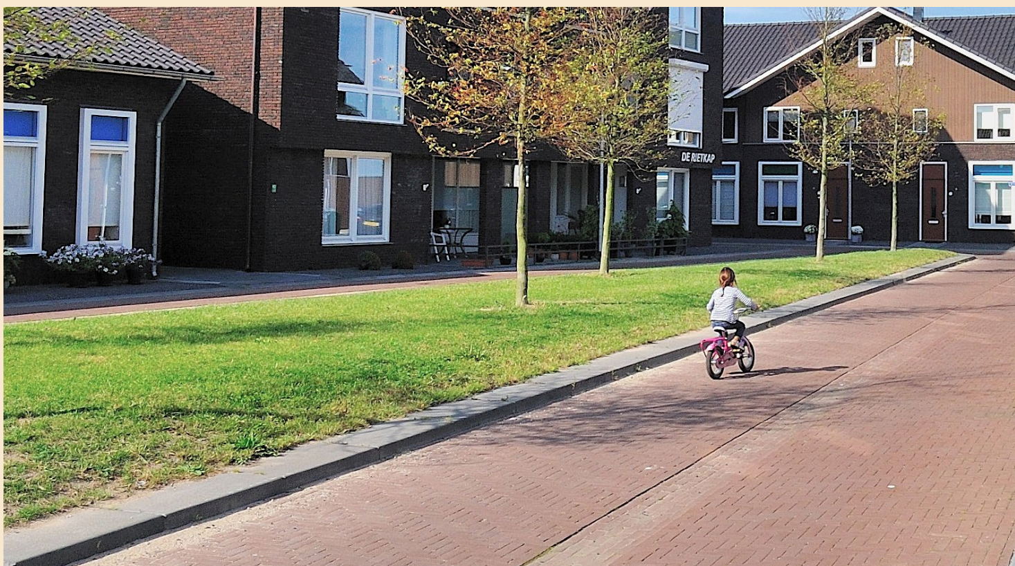
PARKEREN EN OPRITTEN IN WATERDOORLATENDE GRASBETONSTEEN, RIJBAAN VAN BETONKLINKERS IN ROODBRUINE TINT, TROTTOIR VAN GRIJZE BETONTEGELS
