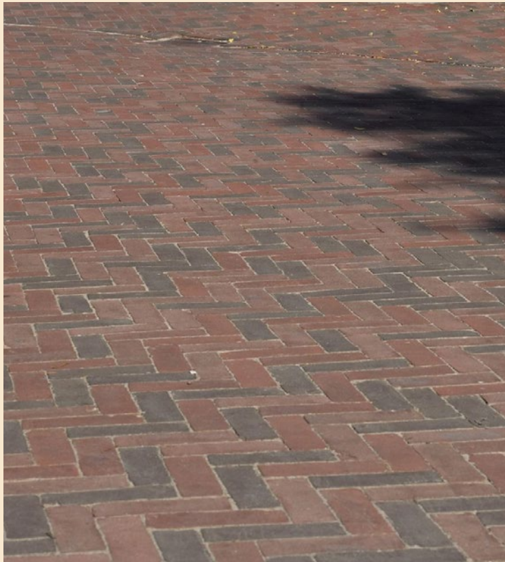
PARKEREN EN OPRITTEN IN WATERDOORLATENDE GRASBETONSTEEN, RIJBAAN VAN BETONKLINKERS IN ROODBRUINE TINT, TROTTOIR VAN GRIJZE BETONTEGELS
