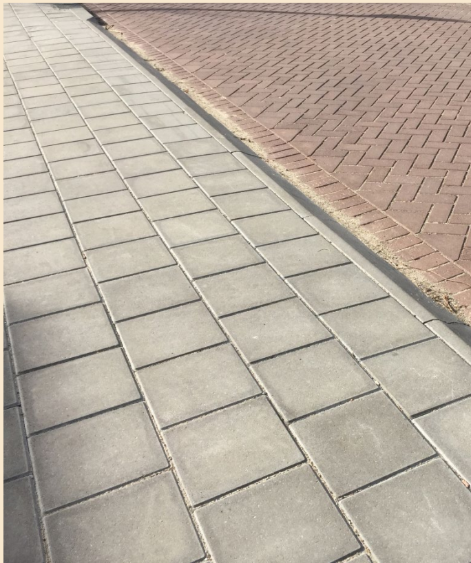
PARKEREN EN OPRITTEN IN WATERDOORLATENDE GRASBETONSTEEN, RIJBAAN VAN BETONKLINKERS IN ROODBRUINE TINT, TROTTOIR VAN GRIJZE BETONTEGELS
