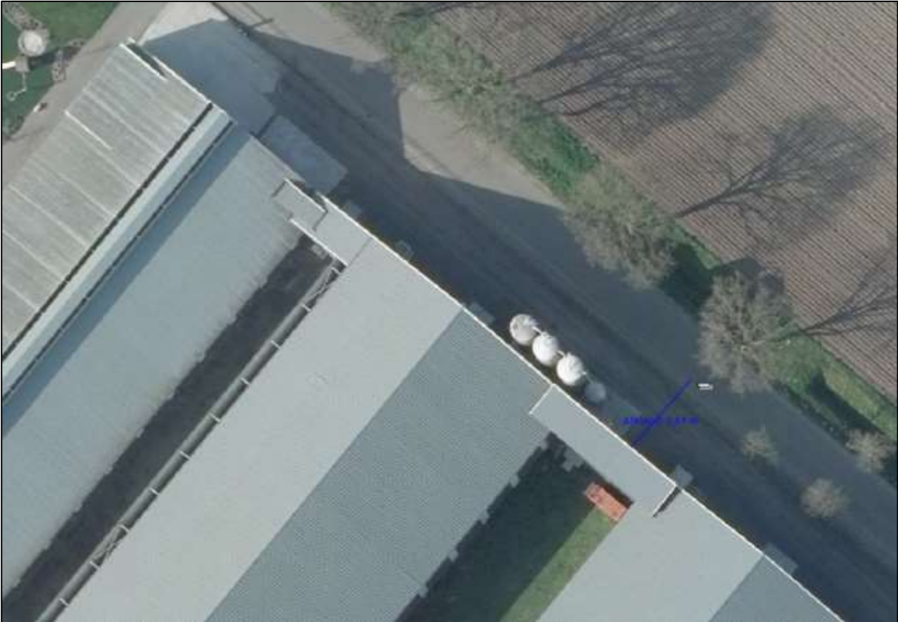
Figuur 6: Afstand bedrijfsgebouwen – rand openbare weg bedraagt ca. 9,5 meter
