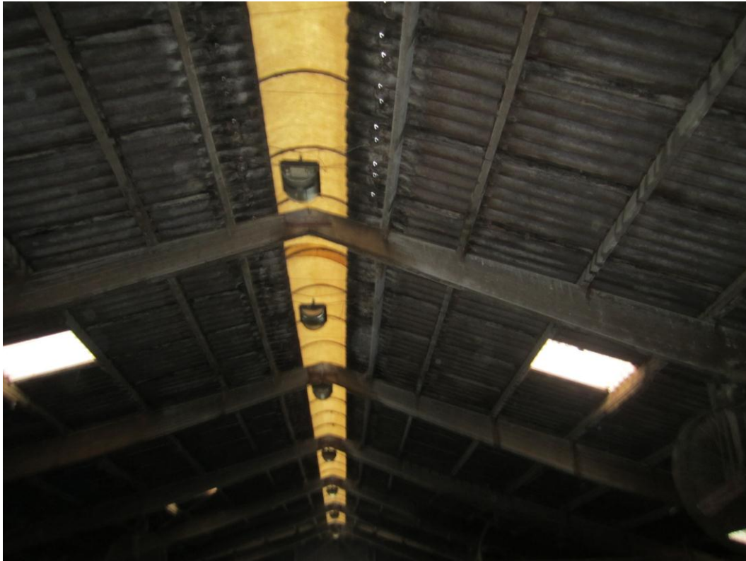
Foto 7. De spanten van de af te breken stal werden geïnspecteerd op het voorkomen van vogelnesten.
