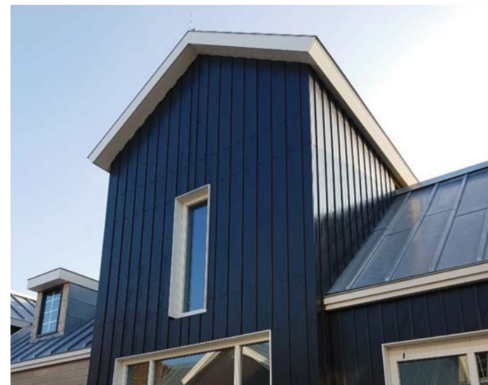
Houten gevel, zinken dak met dakoverstekken.
