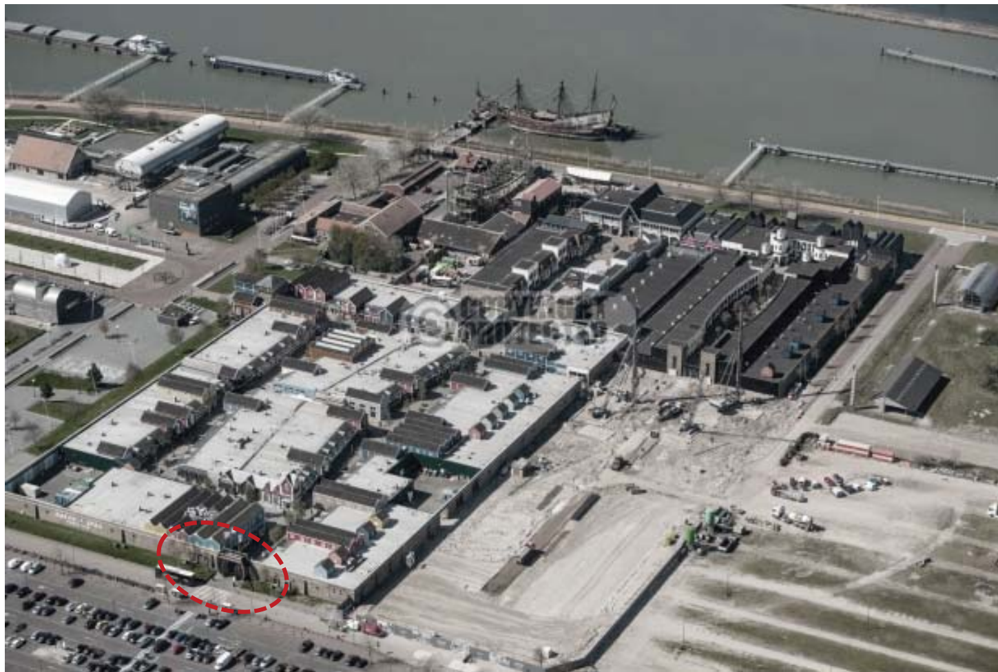
Luchtfoto Batavia Stad met fase 4/5 in aanbouw; Oostpoort/ Welcome Centre in de rode cirkel.
