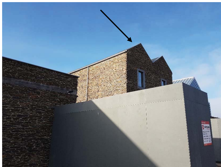
De kantige architectuur van fase 4/5 aan de oostmuur.
