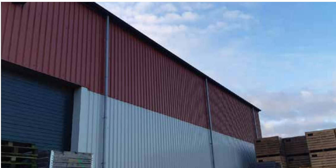
Loods volledig gesloten en opgebouwd uit stalen platen.
