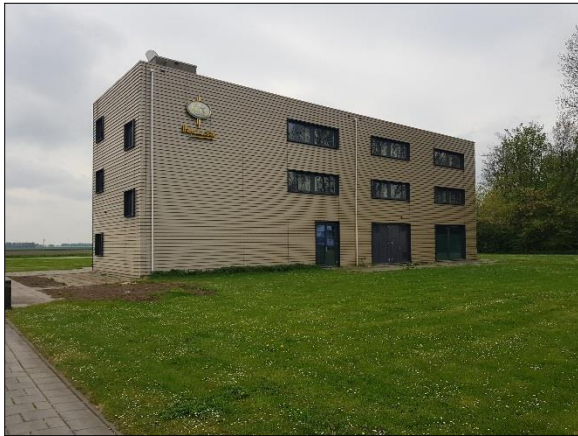
Figuur 5. Gebouw vanuit noordwesten
