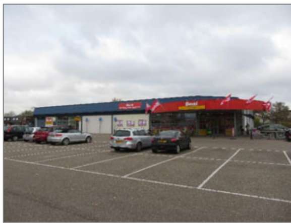
Afbeelding 2.2 De parkeerplaats en supermarkt gezien vanuit het zuiden.
