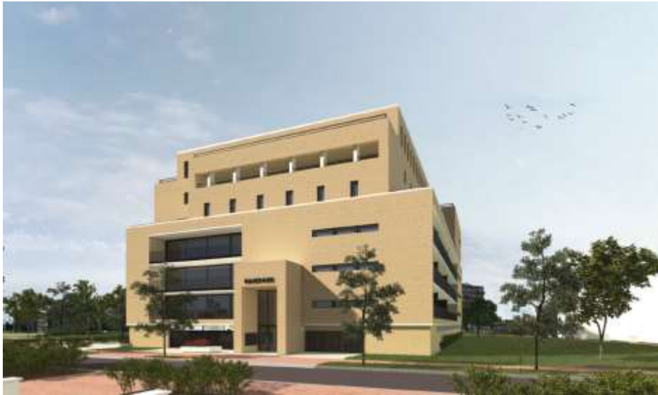
Figuur 4: voorzijde gebouw met een gemarkeerde entree
