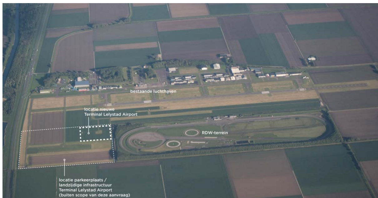
afbeelding 1 - luchtfoto van de bestaande situatie op Lelystad Airport, waarop globaal de ligging van de nieuwe passagiersterminal is aangegeven.
