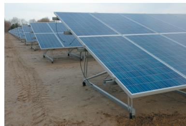
Dubbele opstelling na aanleg.
