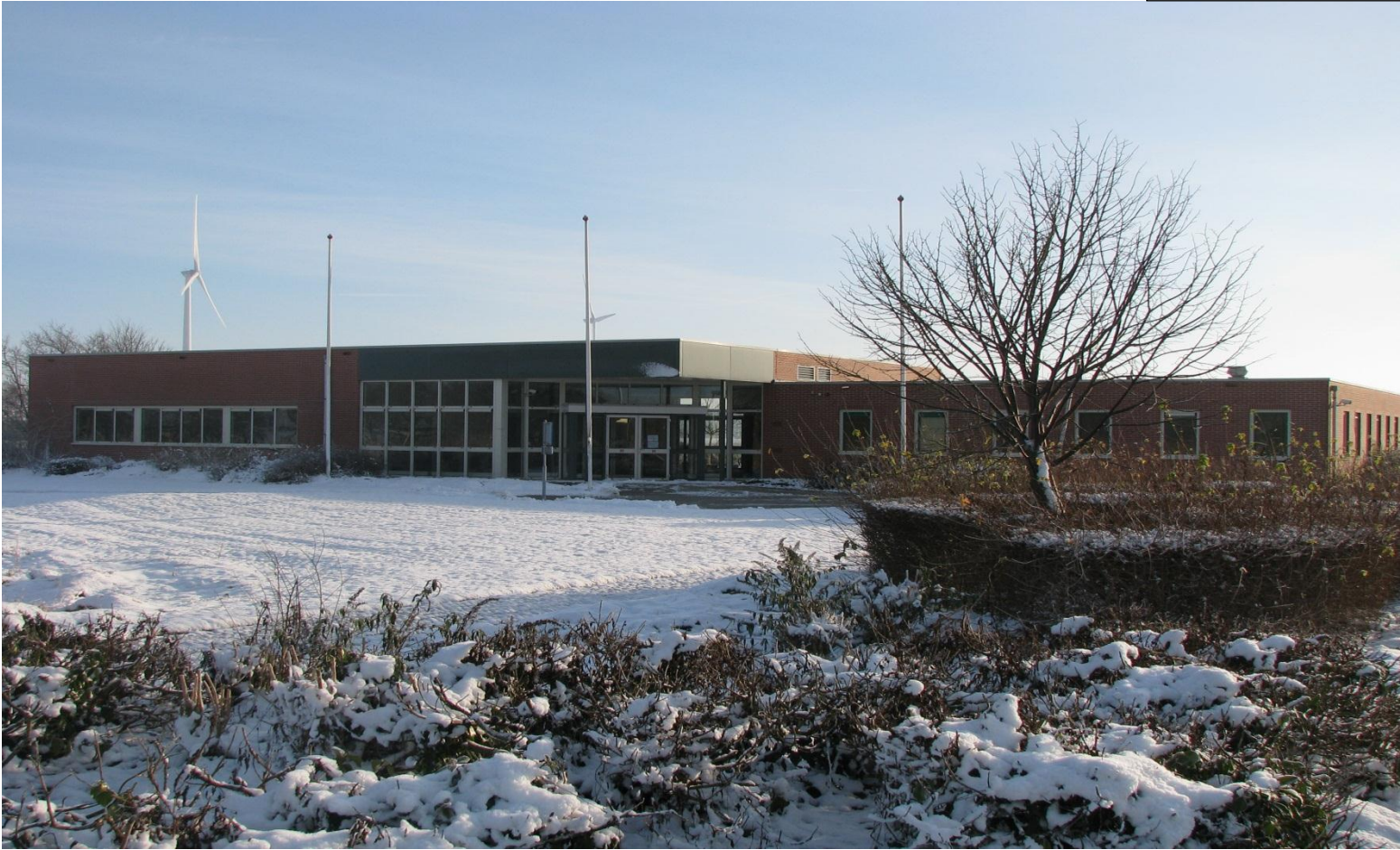
Foto bestaand pand
