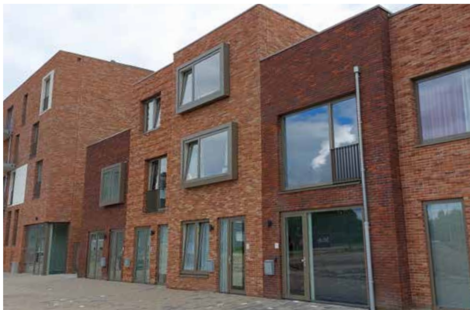
Impressie huidige bebouwing op bouwveld III
