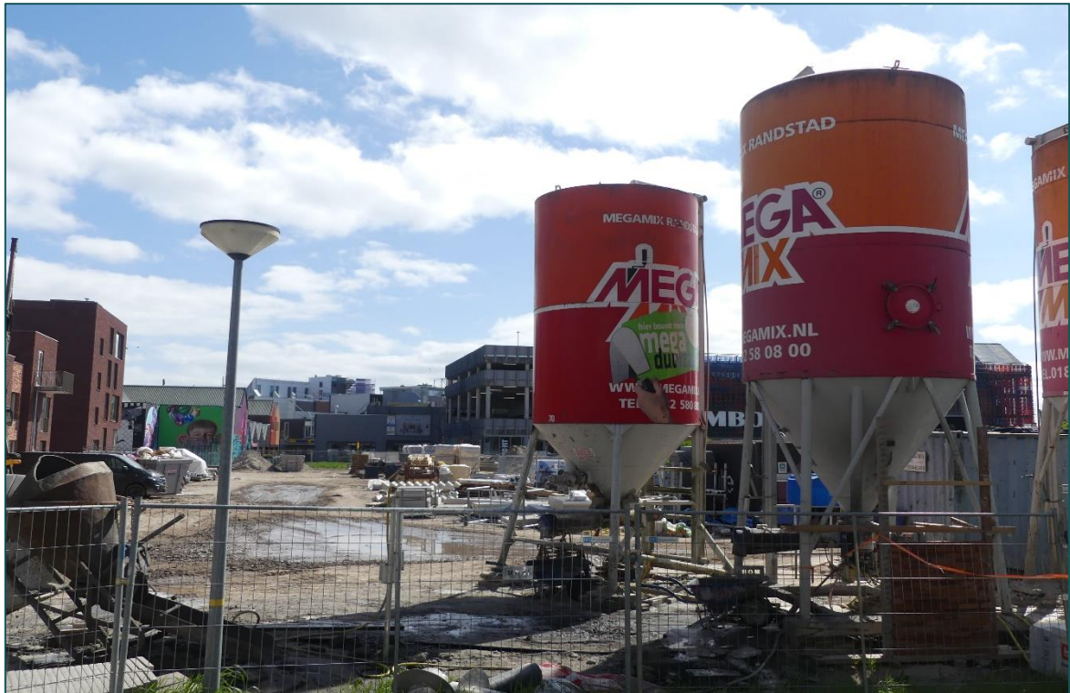
Figuur 3 Een deel van de planlocatie is in gebruik als opslag voor de bouw van naastgelegen appartementen.
