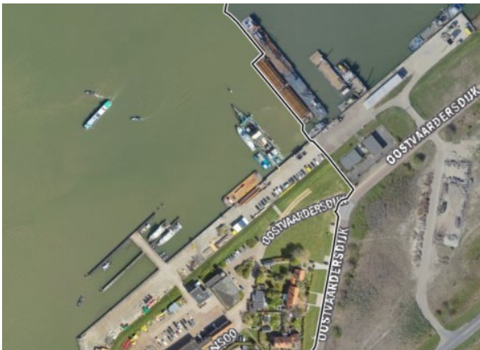
Figuur 5.3 Luchtfoto laad- en loskade
