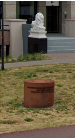
Luchtschacht naar duikers tussen de wadi's
