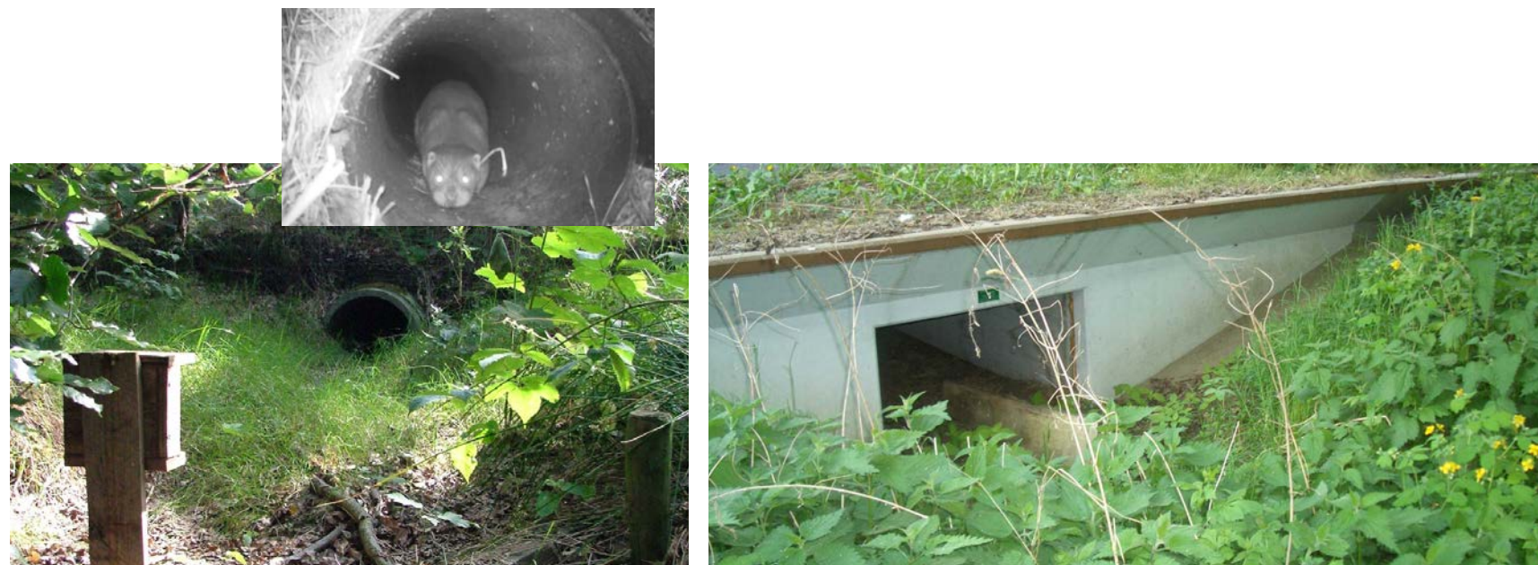
Een impressie van een faunatunnel geschikt voor marterachtigen
