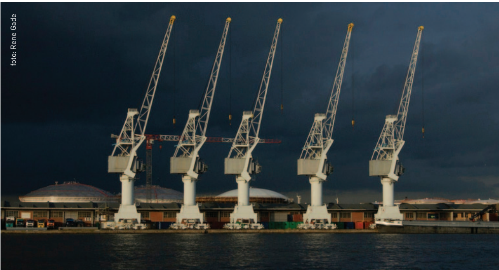
referentie kranen in een kleur afgestemd op de centrale
