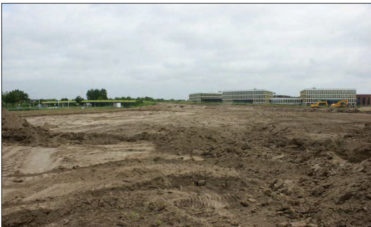
Figuur 2.7 Overzicht Campus Midden bouwrijp met zicht op Zuigerplasdreef.
