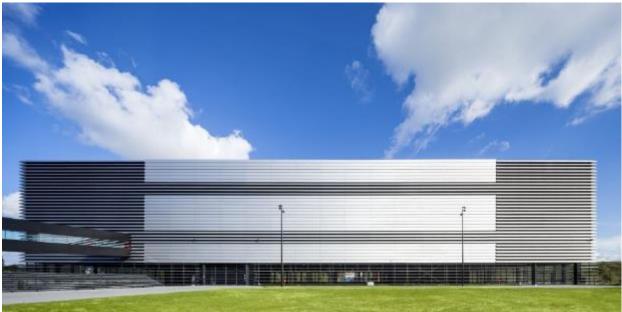
Figuur 2.1 Referentiebeeld datacenter (bron: Mulderblauw)
