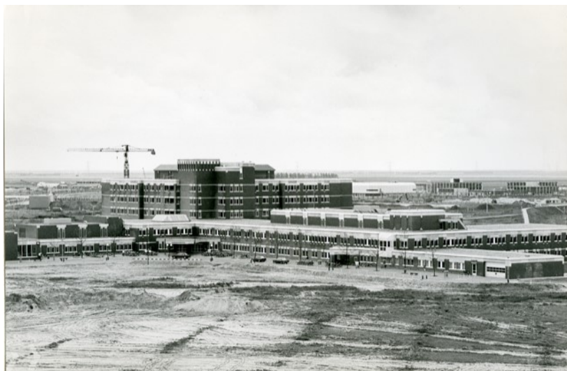
Het ziekenhuis in aanbouw.
