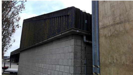
Afbeelding 10. Dakbedekking oude schuren
