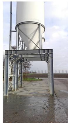
Afbeelding 4. Silo's oostzijde van het bouwblok
