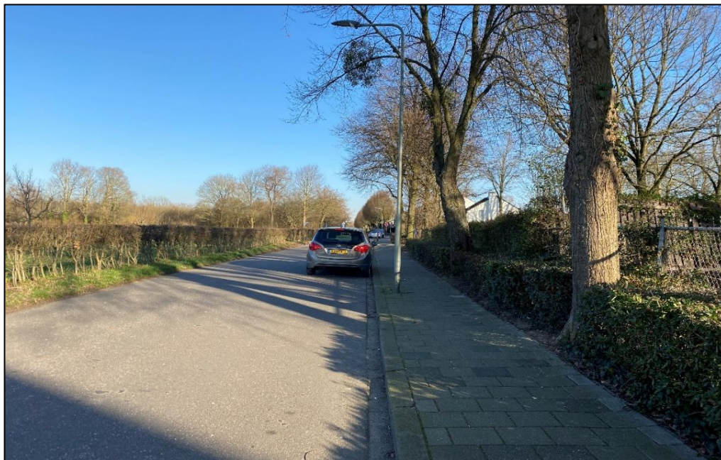
Langen Akker noordzijde projectlocatie
