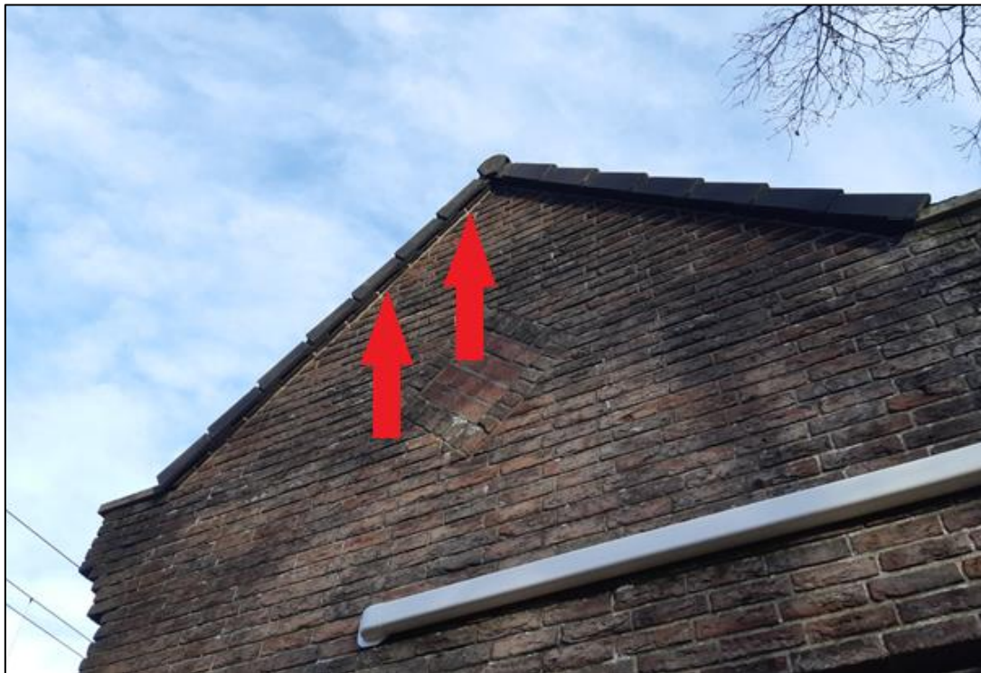
Figuur 3.1 Binnen het huidige onderstation is onder de dakpannen aan de kopse kanten van het gebouw (rode pijl) potentie voor vleermuisverblijfplaatsen aanwezig (Bron foto: D. Pruijs, Ecogroen).
