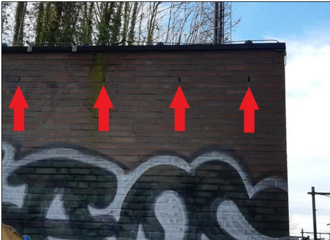
Figuur 3.2 Binnen het gebouw naast het projectgebied waar een nieuw onderstation wordt gerealiseerd zijn spouw-gaten aanwezig die toegang bieden tot de spouwmuur en kan dienen als vleermuisverblijfplaats (Bron foto: D. Pruijs, Ecogroen).
