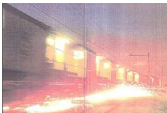
Figuur 2: Het bijlijpen van spoorstaven
