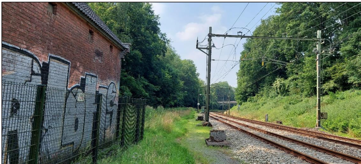
Figuur 3: Huidige situatie, met rechts het spoor en links het schakelstation.
