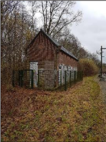
Figuur 5: Huidige situatie, waarop het schakelstation zichtbaar is.
