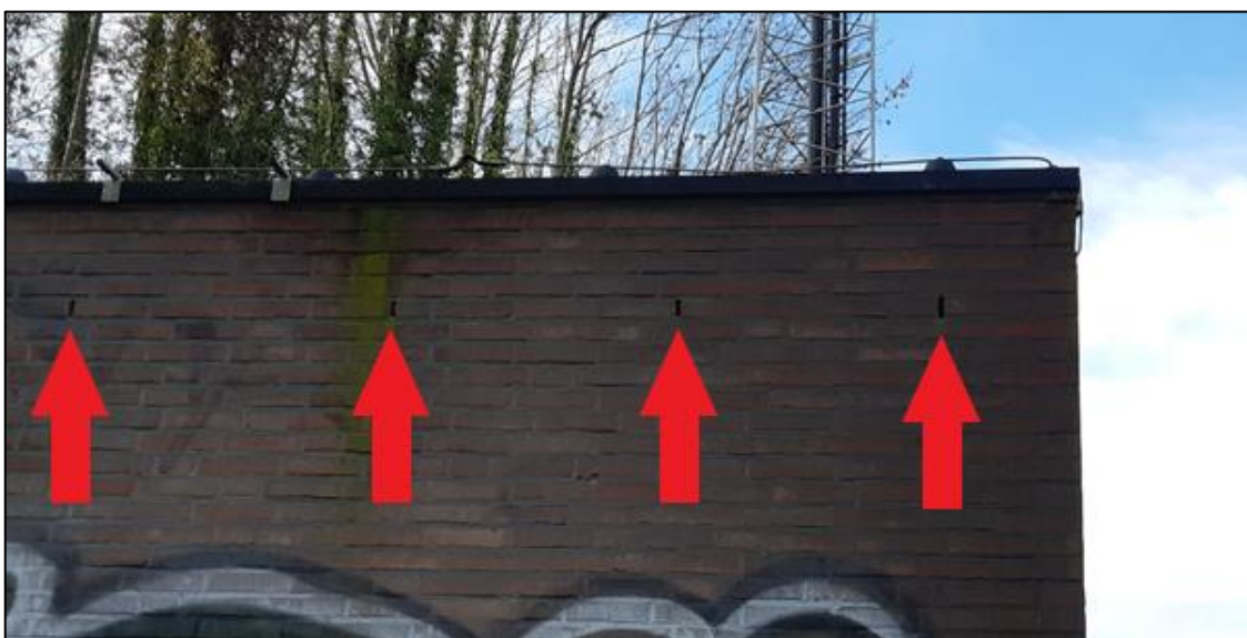
Figuur 3.2 Binnen het gebouw naast het projectgebied waar een nieuw onderstation wordt gerealiseerd zijn spouwgaten aanwezig die toegang bieden tot de spouwmuur en kan dienen als vleermuisverblijfplaats. Bron foto: Ecogroen.
