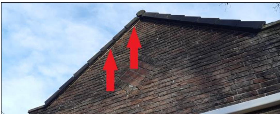
Figuur 3.1 Binnen het huidige onderstation is onder de dakpannen aan de kopse kanten van het gebouw (rode pijl) potentie voor vleermuisverblijfplaatsen aanwezig. Bron foto: Ecogroen.
