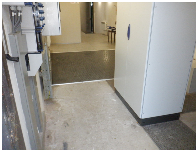
betonnen vloer en later aangebrachte systeemvloer
