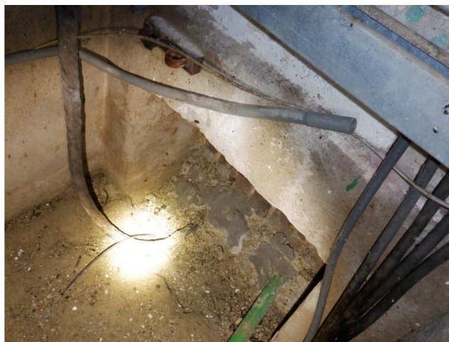
geen verdachte materialen in de kabelgoot
