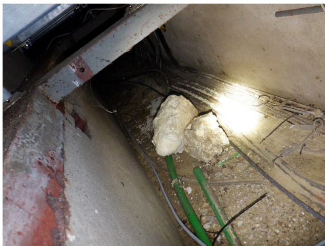
geen verdachte materialen in de kabelgoot
