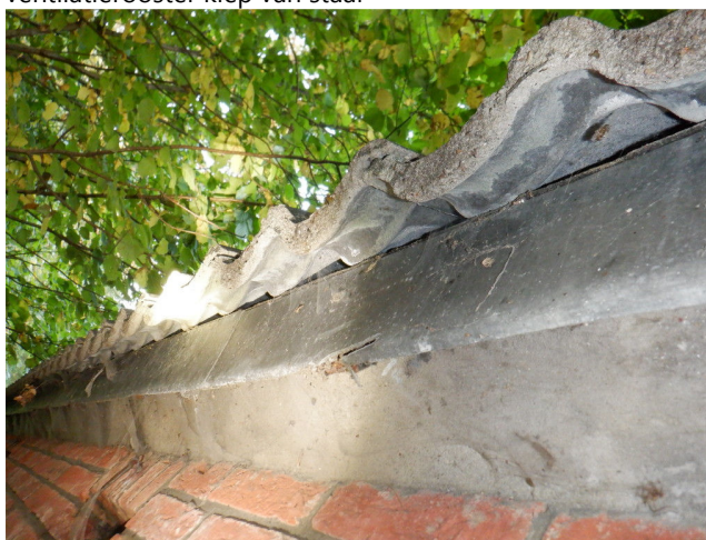
dakrand van zink op beton
