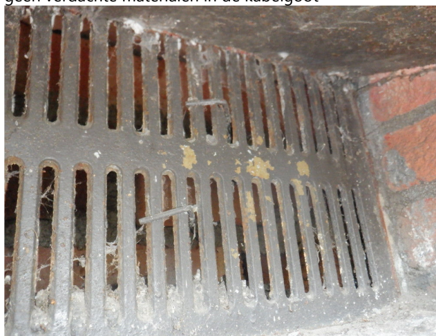
roosters dichtgemetseld van binnen
