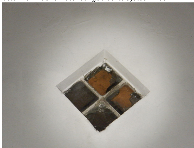
dichtgemetselde glasblokken raam met houten plaat
