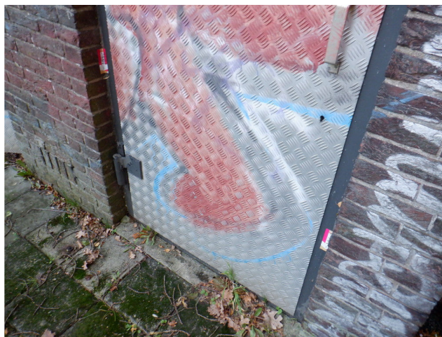
deuren niet asbestverdacht
