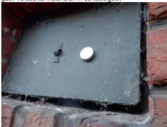
ventilatiooroster klep van staal
