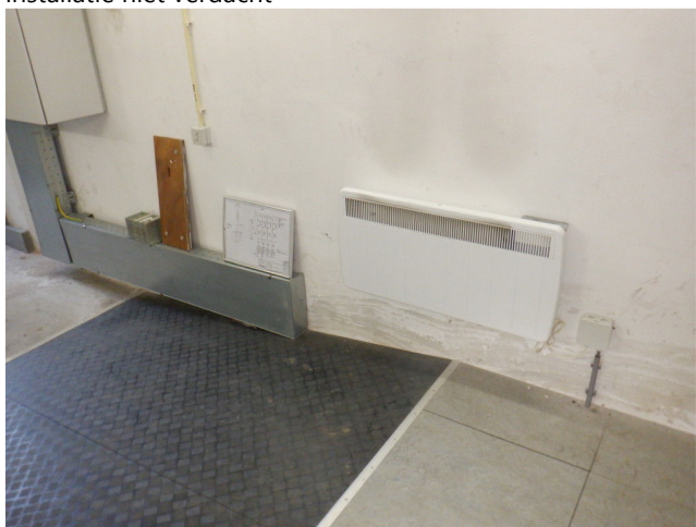
radiatoren niet asbestverdacht
