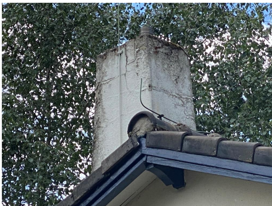
Foto 1: De dakconstructie is ongeschikt voor broedvogels met jaarrond beschermde nesten. Zo is te zien dat de nokpannen met beton zijn afgedicht, waardoor er geen plek is voor gierzwaluwen om deze te gebruiken. Ook de dakconstructie aan de kapse kant is vanwege het gladde houtwerk ongeschikt om als invliegplek te dienen
