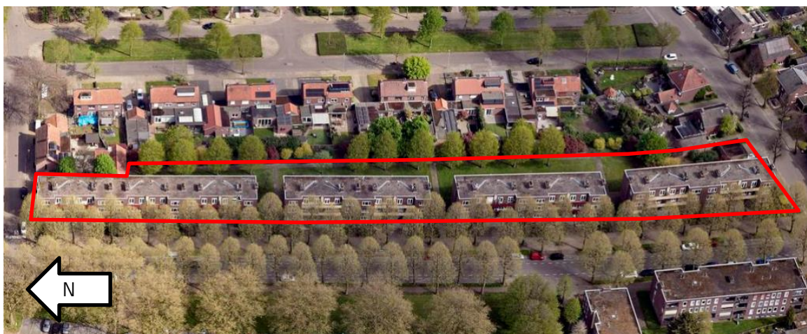
Figuur 4: de vier zuidelijk gelegen appartementencomplexen (luchtfoto oostelijk gericht)
