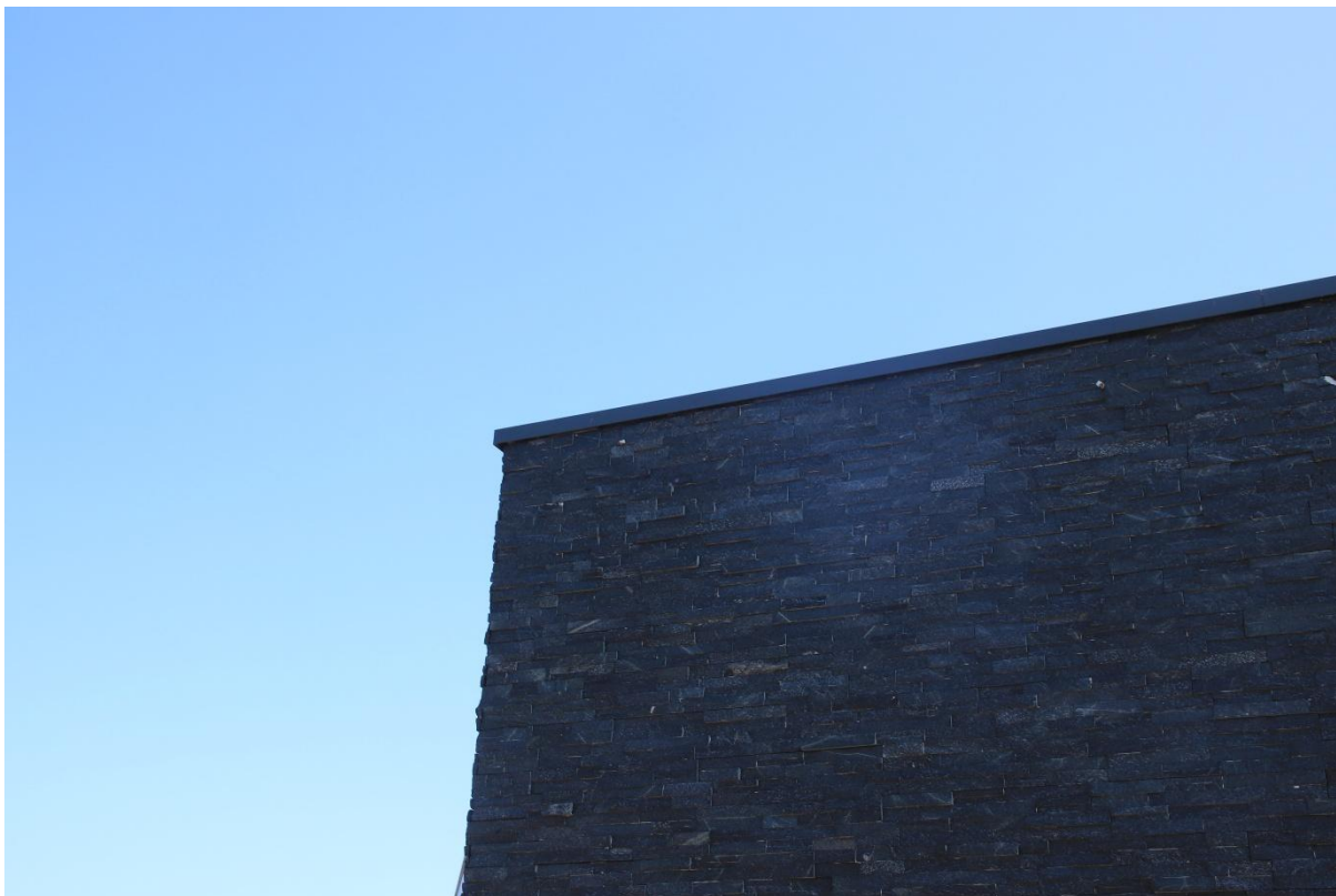
Foto 6: Het gemetselde kantoordeel heeft nergens geschikte invliegopeningen en/of open stootvoegen en is ongeschikt om te dienen als vaste rust- en verblijfplaats voor vleermuizen
