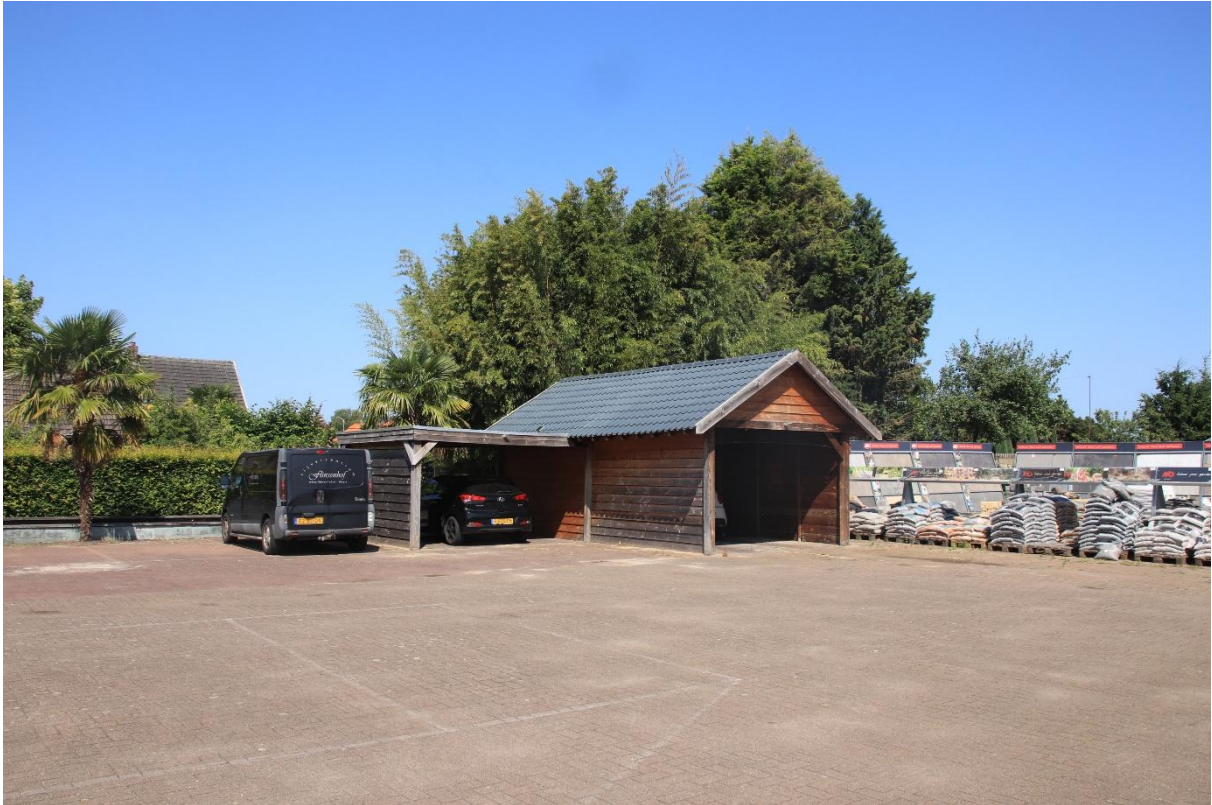
Foto 1: Beeld op een van de te verwijderen stallingen en de stenen opslag
