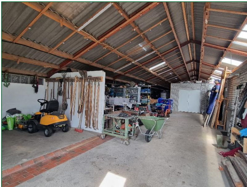
Afbeelding 22. Bedrijfsgebouw met stalling en opslag, werkplaats en ruimte voor het drogen van eigen kruiden en specerijen
