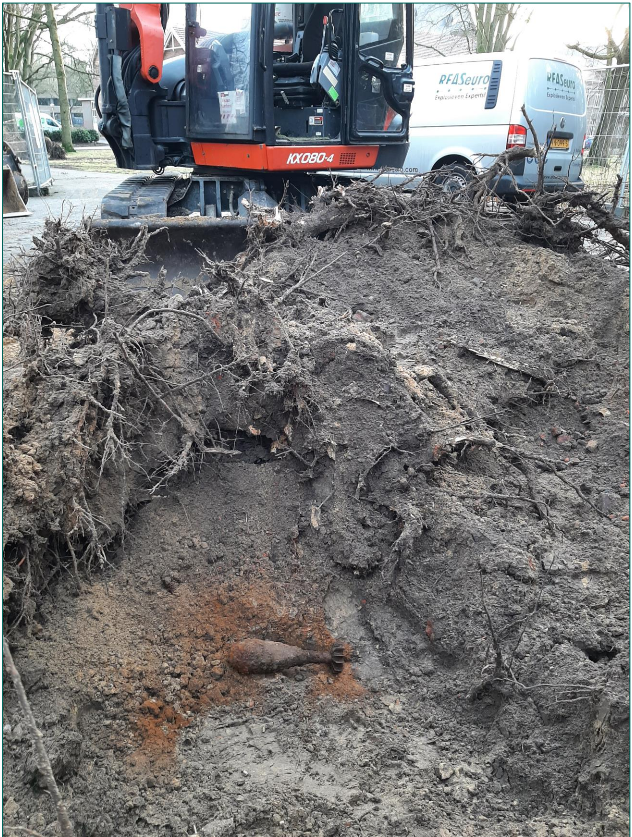
Figuur 48: Voorbeeld van NGE die tussen de boomwortels is aangetroffen, in dit geval een 8 cm mortiergranaat.
