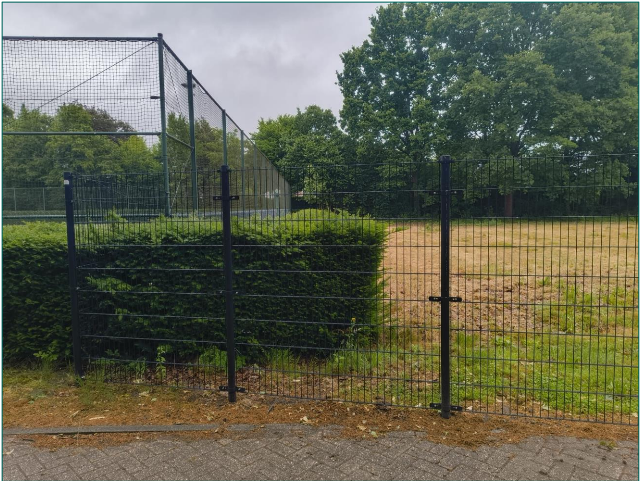
Figuur 123: Foto van het hekwerk in het zuidelijk van de tennisbaan.
