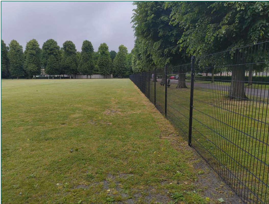
Figuur 81: Foto van het hekwerk behorende bij het voetbalveld. Foto genomen in noordelijke richting.
