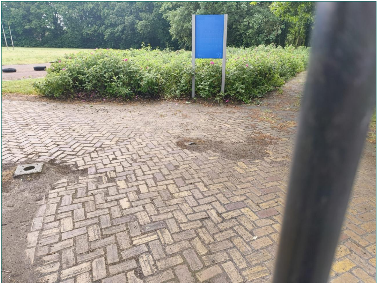
Figuur 133: Foto van de verharding nabij de toegangspoort in het noordwesten van de atletiekbaan.
