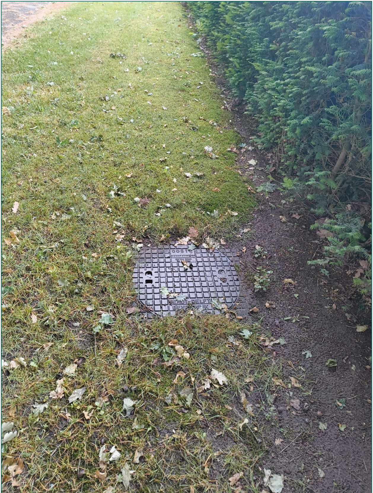
Figuur 112: Foto van een putdeksel van een inspectieput van het riool.
