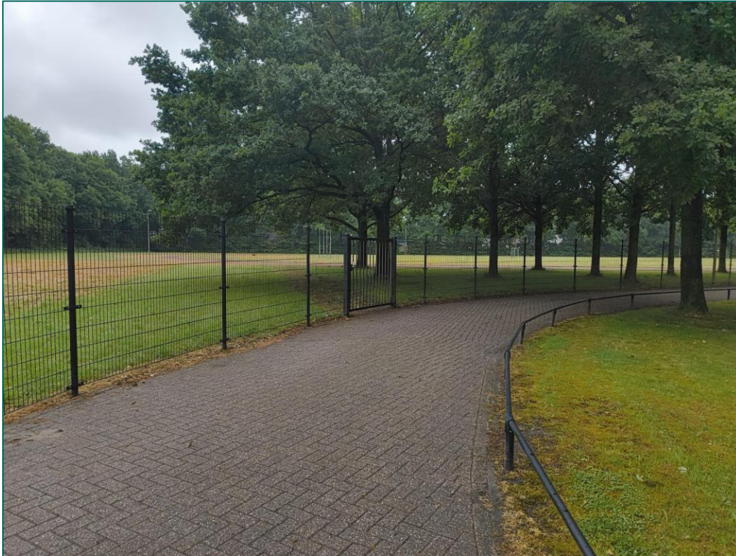
Figuur 124: Foto van de atletiekbaan, genomen vanaf het noorden. Op verschillende plaatsen zijn lichtmasten aanwezig.
