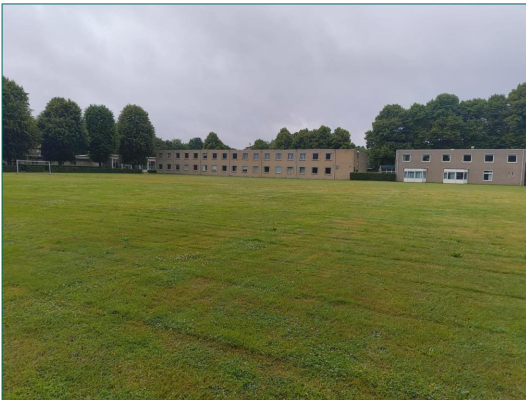
Figuur 84: Foto van de bebouwing die ten westen van het voetbalveld is gesitueerd.
