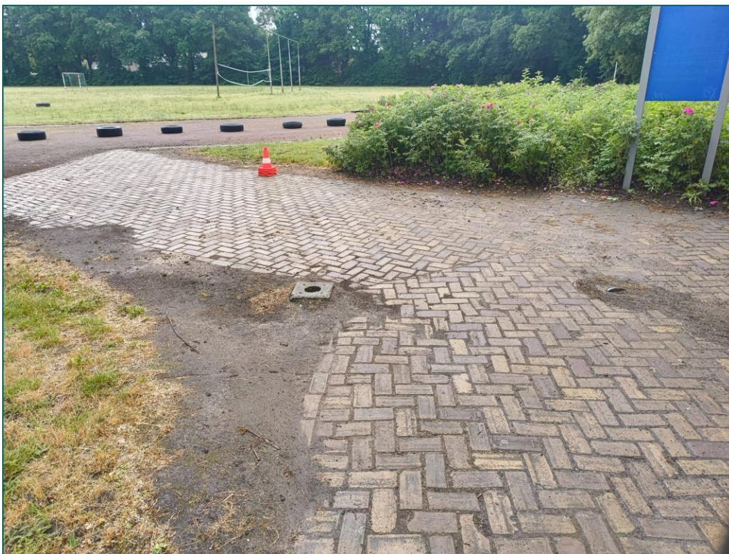
Figuur 132: Foto van de verharding nabij de toegangspoort in het noordwesten van de atletiekbaan.
