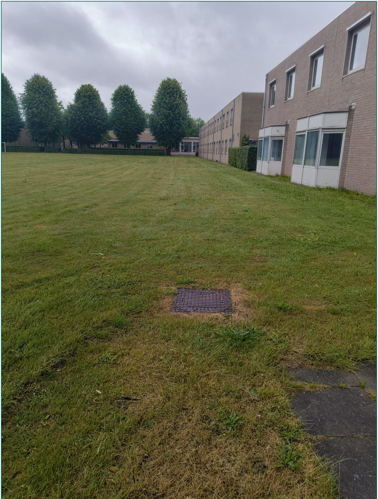
Figuur 95: Foto van ijzeren putdeksel van het riool naast de bebouwing in het westelijk deel van het voetbalveld.
